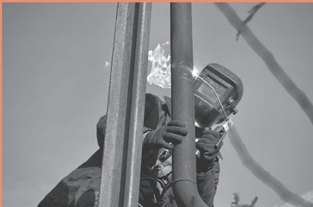
■ Wymiana rur gazowych Fot. Anhelina Fesenko
