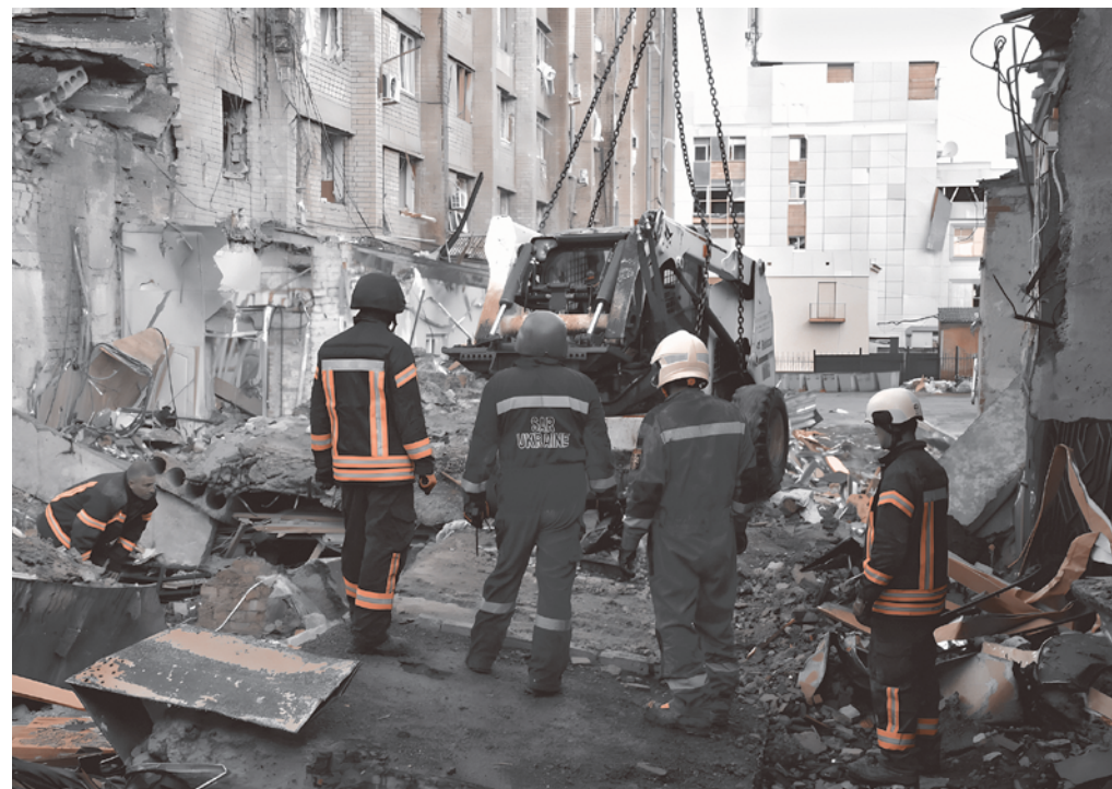
Ładowarka bobcat połączona z żurawiem Fot. Biuro Prasowe Rady Miasta Kramatorska
